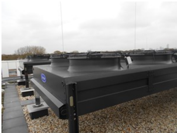
Afb. 10.12 Luchtgekoelde condensor (drycooler) (bron: Carrier)
