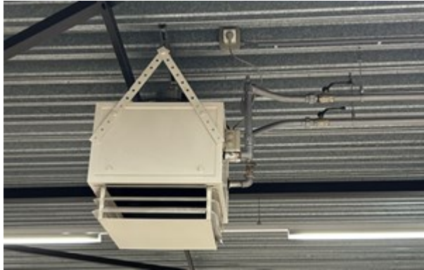
Afb. 9.22 Indirect gestookte luchtverhitter
