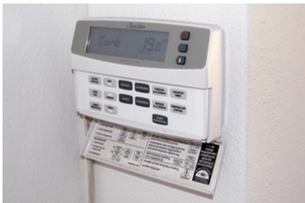
Afb. 9.77 Klokthermostaat (centrale regeling)
