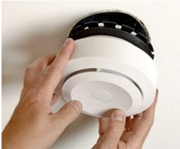
Afb. 11.14 Toevoerrooster mechanische ventilatie
