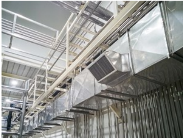
Afb. 11.59 Ongeïsoleerde luchtkanalen
