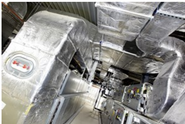
Afb. 11.58 Geïsoleerde luchtkanalen (bron: Rockwool)
