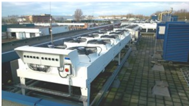
Afb. 10.17 Luchtgekoelde condensor met afgifte aan de buitenlucht
