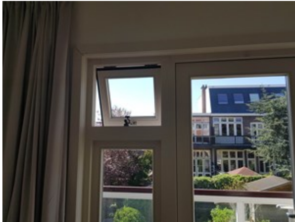
Afb. 11.7 Klepraam voor natuurlijke luchttoevoer
