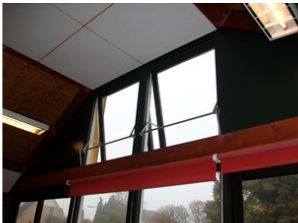
Afb. 11.6 Te openen raam voor natuurlijke luchttoevoer
