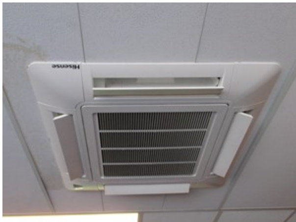
Afb. 10.10 Binnenunit van een splitsysteem (verdamper)
