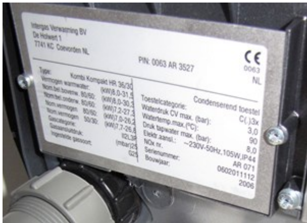
Afb. 9.13 Typeplaatje van een verwarmingstoestel
