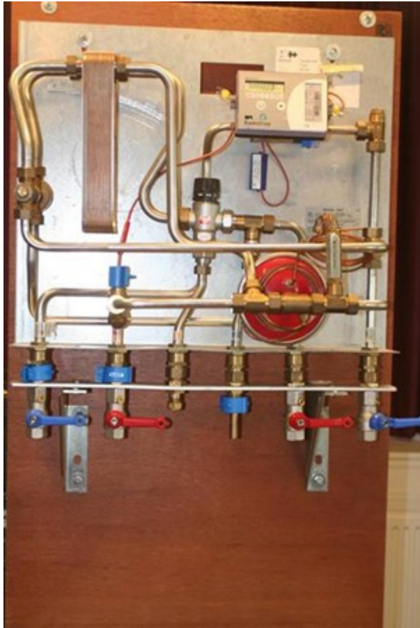
Afb. 13.9 Binnenwerk van een afleverset
