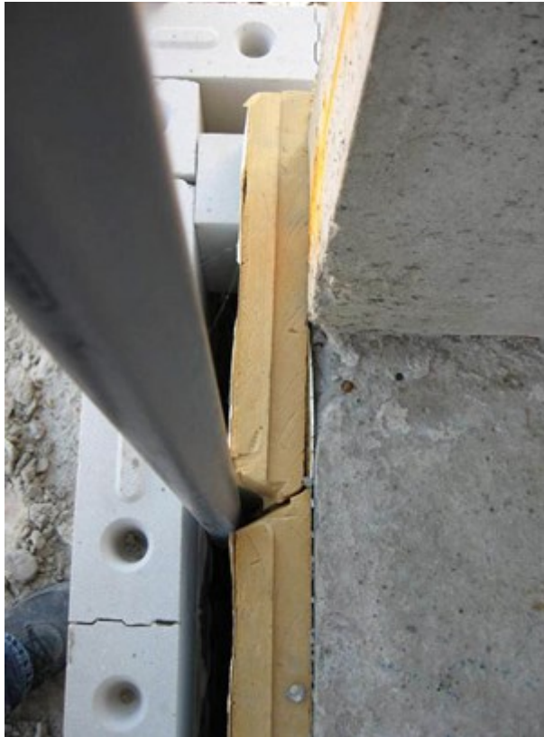
Afb. 8.44 Onderbreking van het isolatiemateriaal
