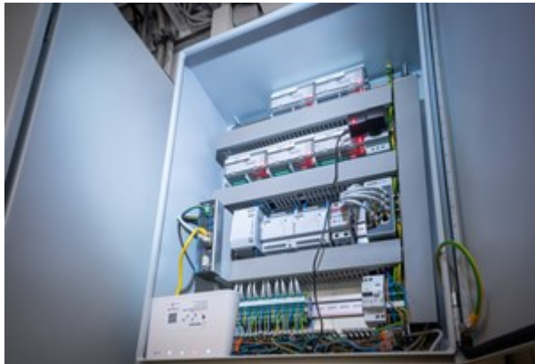
Afb. 14.1 Verlichtingsmanagementsysteem t.b.v. centrale aansturing (bron: Trilux)
