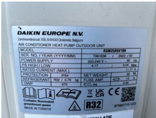
Afb. 10.3 Typeplaatje warmtepomp
