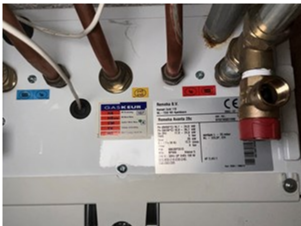
Afb. 9.14 Typeplaatje HR107 CV ketel
