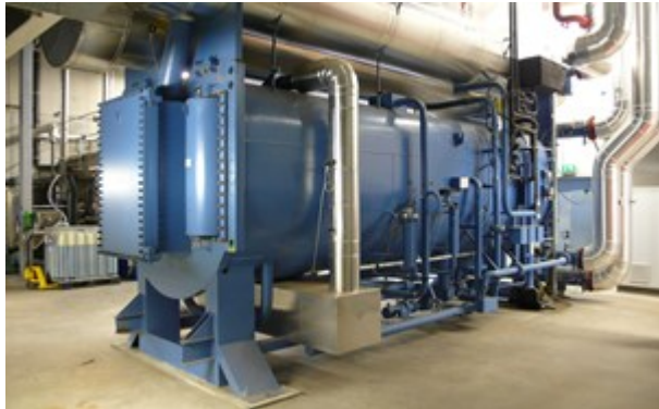
Afb. 10.21 Absorptiekoelmachine
