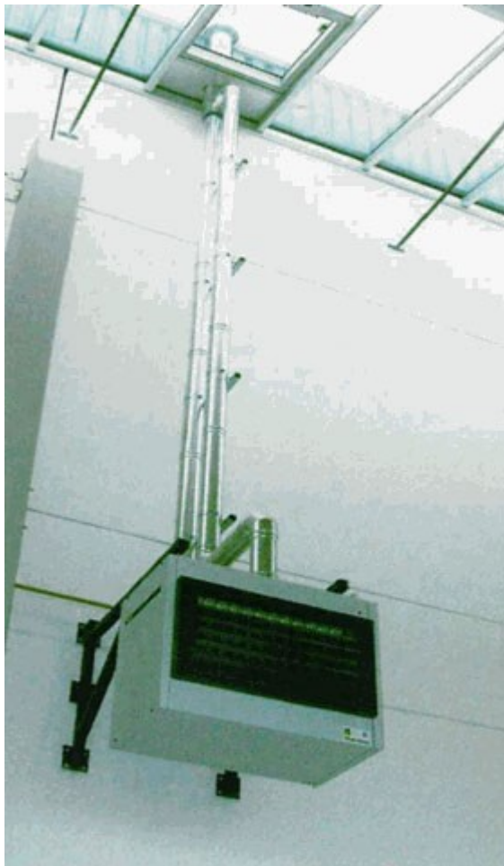
Afb. 9.23 Direct gestookte luchtverhitter
