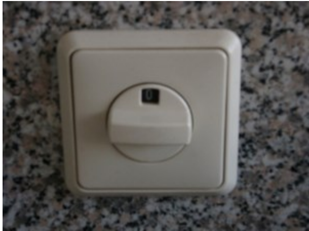
Afb. 11.37 Driestandenschakelaar voor ventilatie
