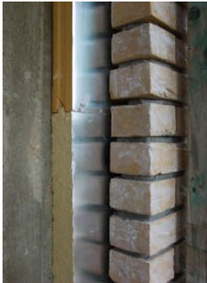
Afb. 8.37 Isolatiemateriaal sluit goed aan zowel onderling als op het binnengevelblad (bron: Nieman)
