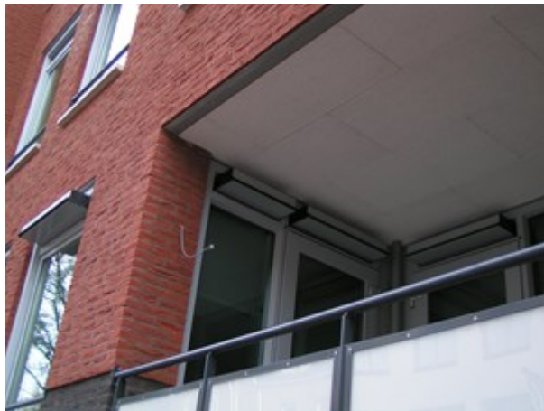
Afb. 11.8 Suskasten boven een raam
