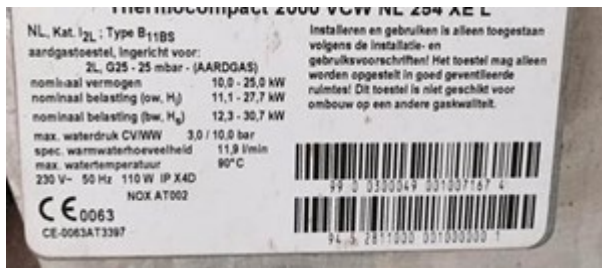
Afb. 9.45 Nominaal vermogen gasketels, 25 kW
