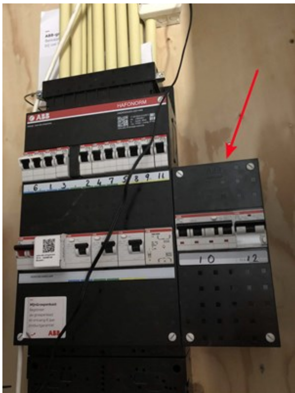
Afb. 15.8 Extra groepen in meterkast voor het PV-systeem
