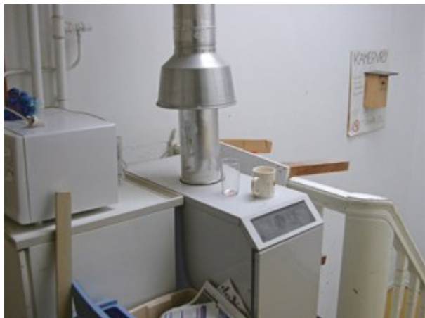
Afb. 9.19 Open toestel met trekonderbreker
