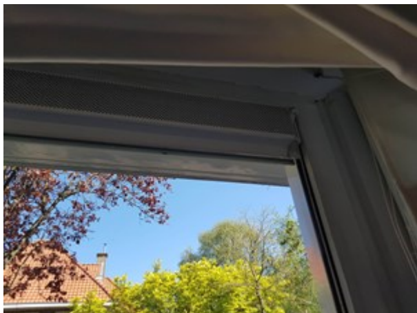
Afb. 8.15 Voorbeeld van een ventilatiooster boven raam
