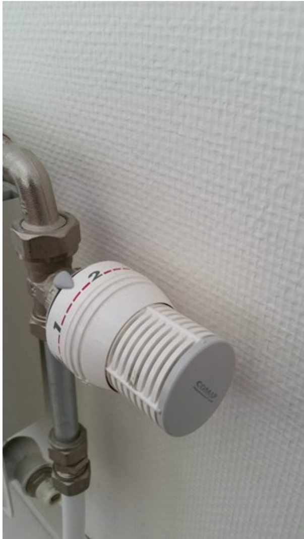
Afb. 9.78 Radiatorthermostaat (naregeling)
