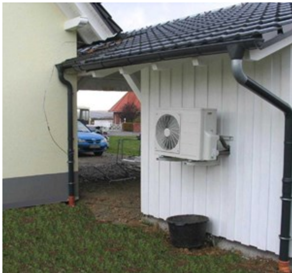
Afb. 10.19 Buitenunit lucht/water-warmtepomp
