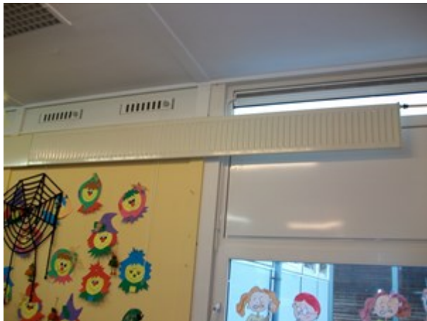
Afb. 11.5 Ventilatie-rooster boven een raam
