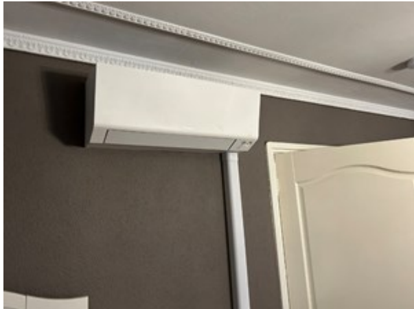
Afb. 10.27 Binnenunit voor lokale koeling (splitsysteem, unit hoog aan de wand)
