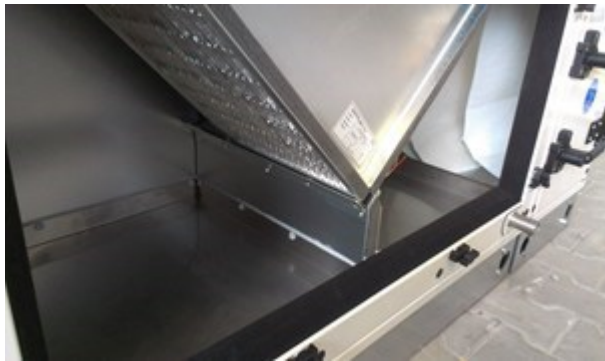
Afb. 11.42 Kruisstroomwisselaar in luchtbehandelingskast
