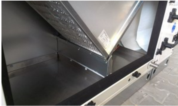
Afb. 11.44 Twin-coil systeem in een luchtbehandelingskast
