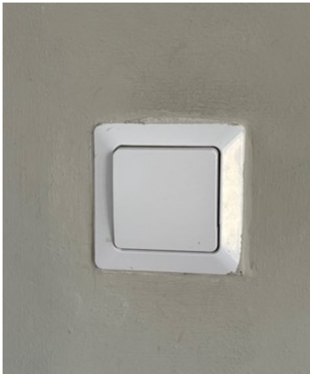
Afb. 14.2 Handmatige aan/uitschakelaar (vertrekschakeling)
