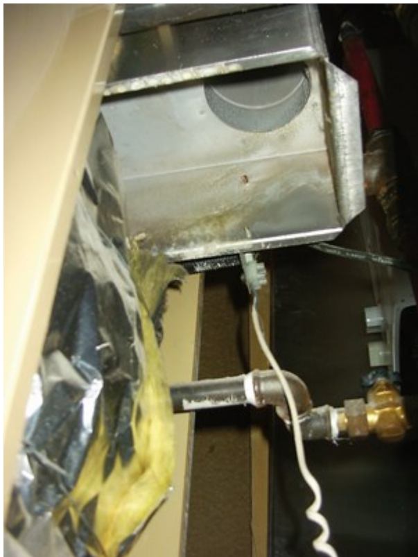
Afb. 9.21 Open toestel met trekonderbreker
