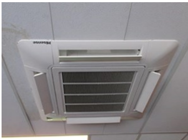
Afb. 10.28 Binnenunit van een splitsysteem (inbouw in plafond)
