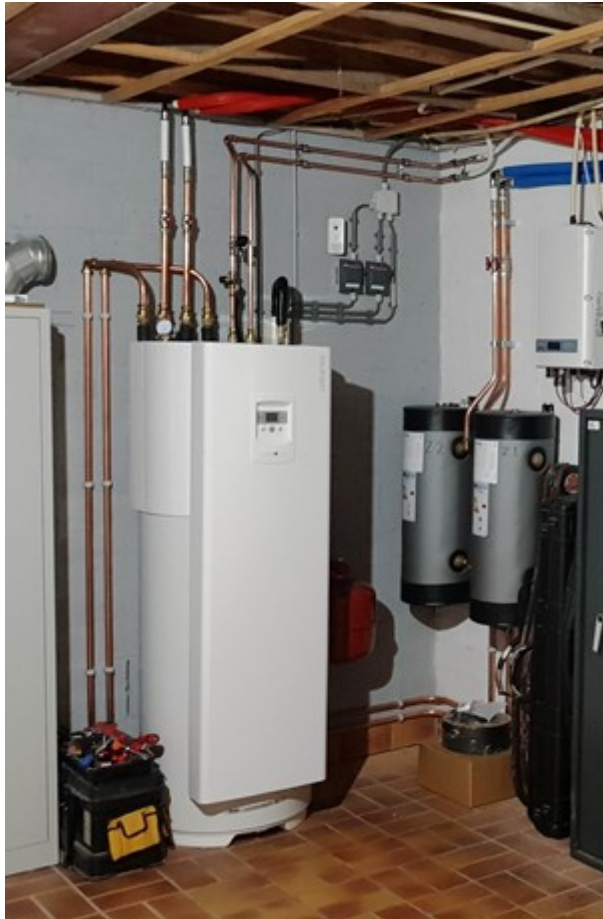
Afb. 10.20 Binnenunit lucht/water-warmtepomp
