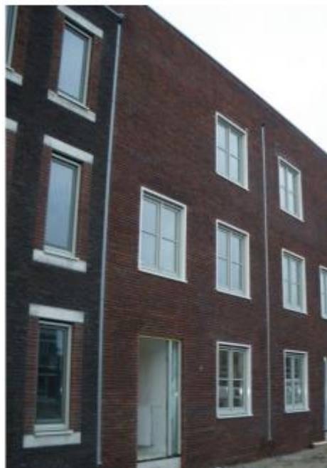
Platdak hoog aan voorgevel
