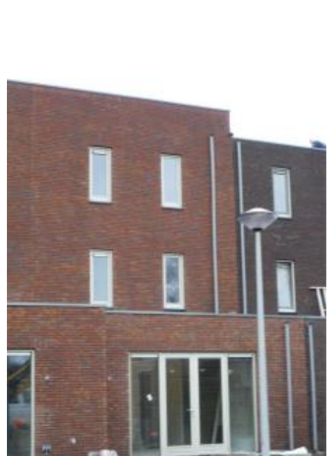
Platdak laag aan achtergevel
